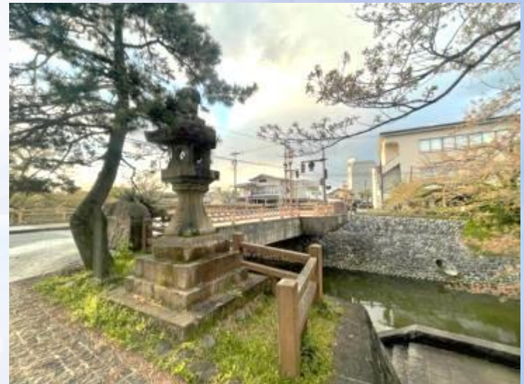
舟橋南側（南東側）の常夜灯
