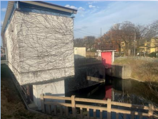
松川水門（左）と松川 (護国神社側から下流) 右上、赤い水門は松川の下流
