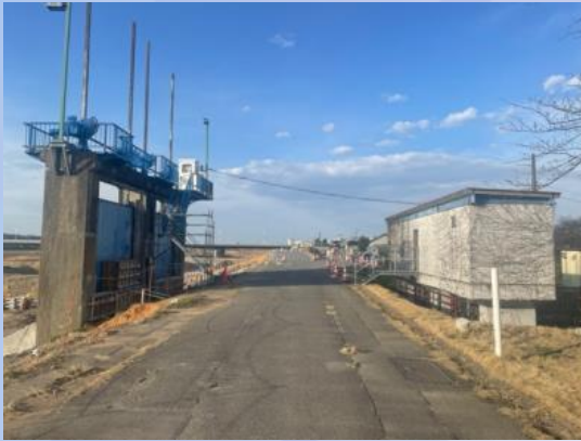
松川放水門（左）と松川（右）
