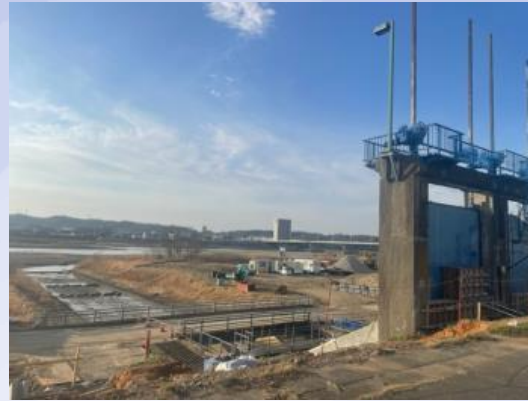
松川放水門から神通川岸
